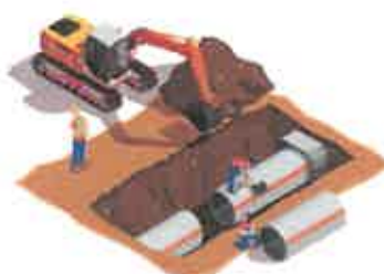
Travaux en cours d'eau
